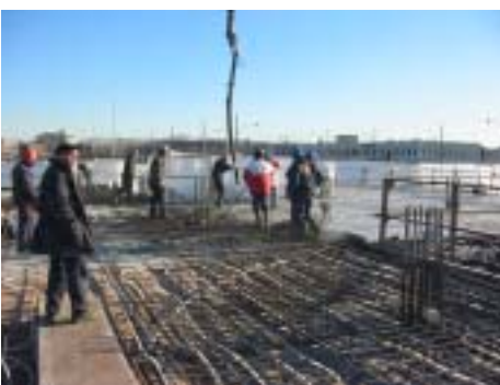
FIGURE F4.3 STRUCTURAL SLAB 2 ND POUR DEC. 18 TH , 2002
